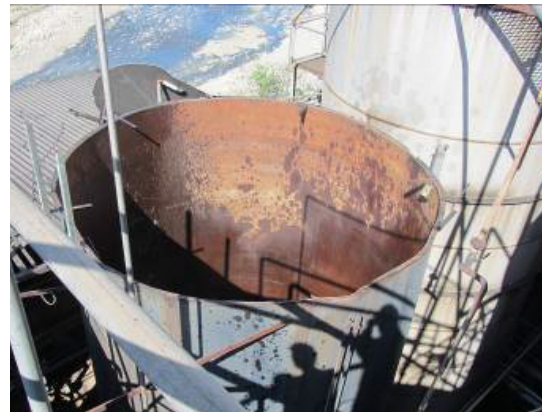
Toàn bộ hình ảnh bồn dầu sau khi xảy ra vụ nổ 甘油槽全貌
