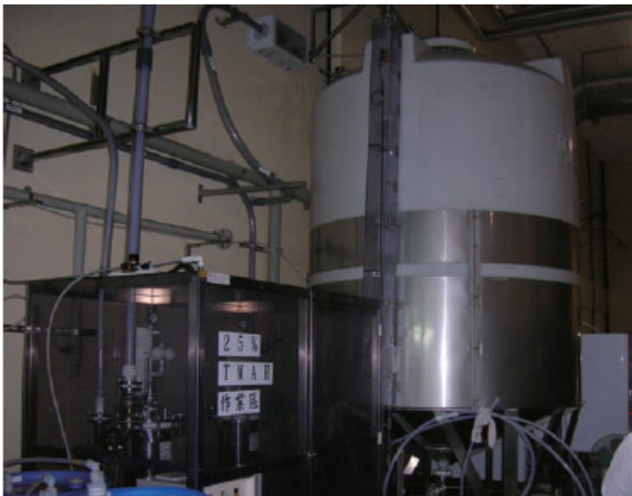
Gambar sisa cairan TMAH TMAH 溶液輸送系統現場圖
